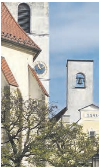
Bei der Christuskirche verbergen sich fünf Klangkörper im Turm hinter den Schalbrettern der Glockenstube (links oben), die kleinste („Tauf“-)Glocke zeigt sich selbstbewusst offen am Dachreiter.
