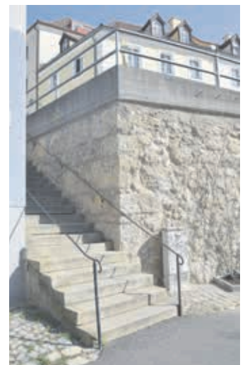
Stützmauer neben der „Übler-Treppe“, evtl. mit Steinen aus einem romanischen Stadttor?
